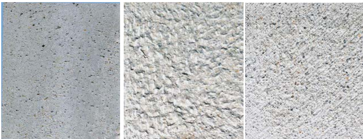
Bild 5: Betonoberflächen: links: sandgestrahlt; Mitte: gestockt rechts: scharriert [6]
