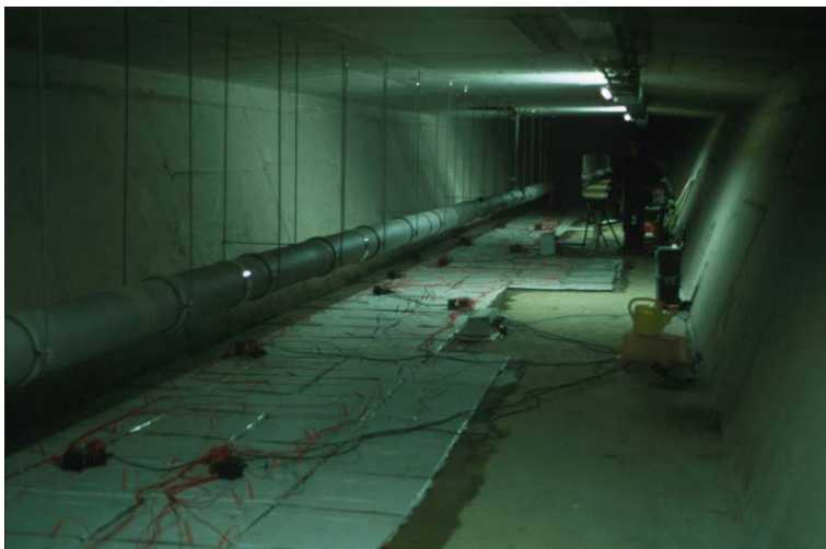
Bild 12: Chloridextraktion an der Bodenplatte eine Brückenhohlkastens [16]
